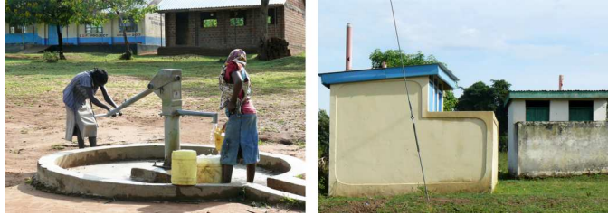
St. James Koteko: Brunnen, neuer und alter Sanitärblock
