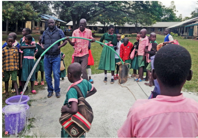
Das erste Wasser (noch mit provisorischer Pumpe)
