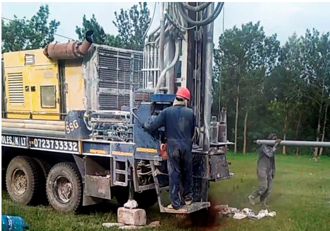
Brunnenbohrung an der Schule von Adurukoit
